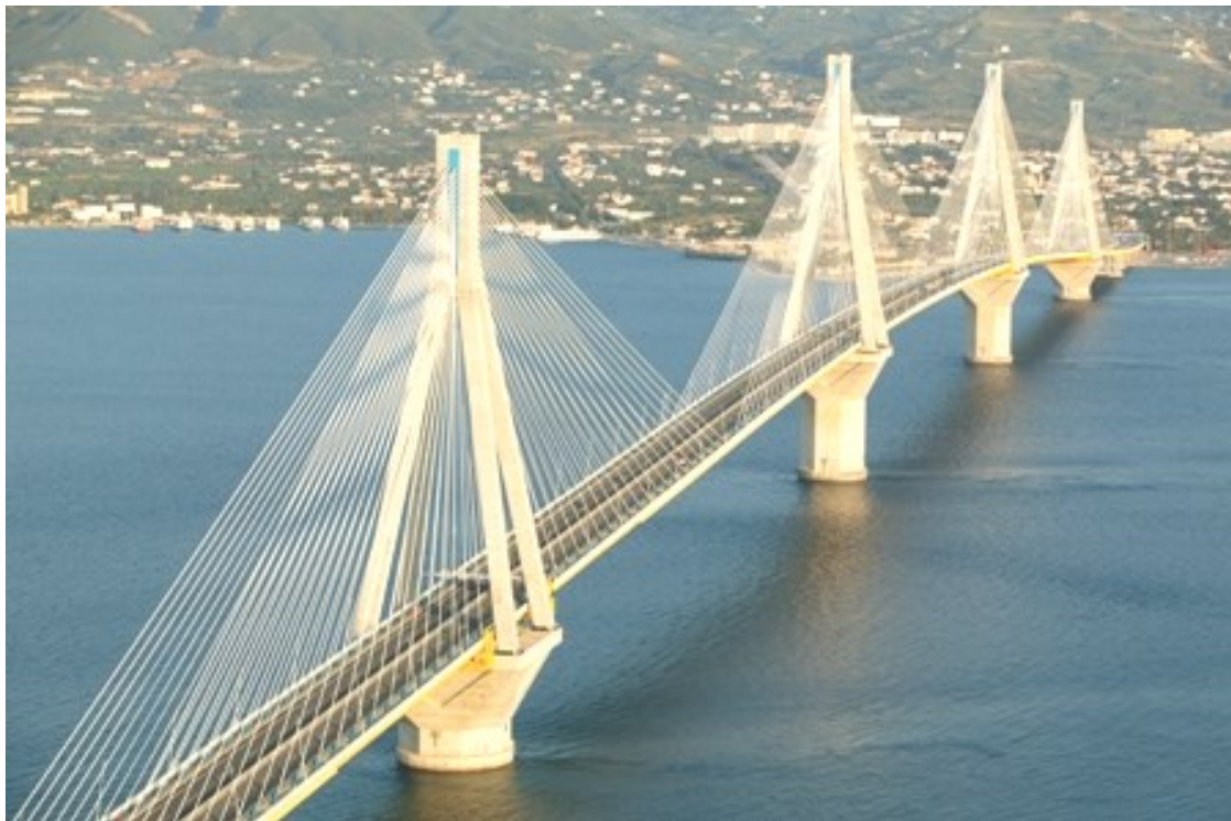
Γέφυρα Ρίου – Αντιρρίου
