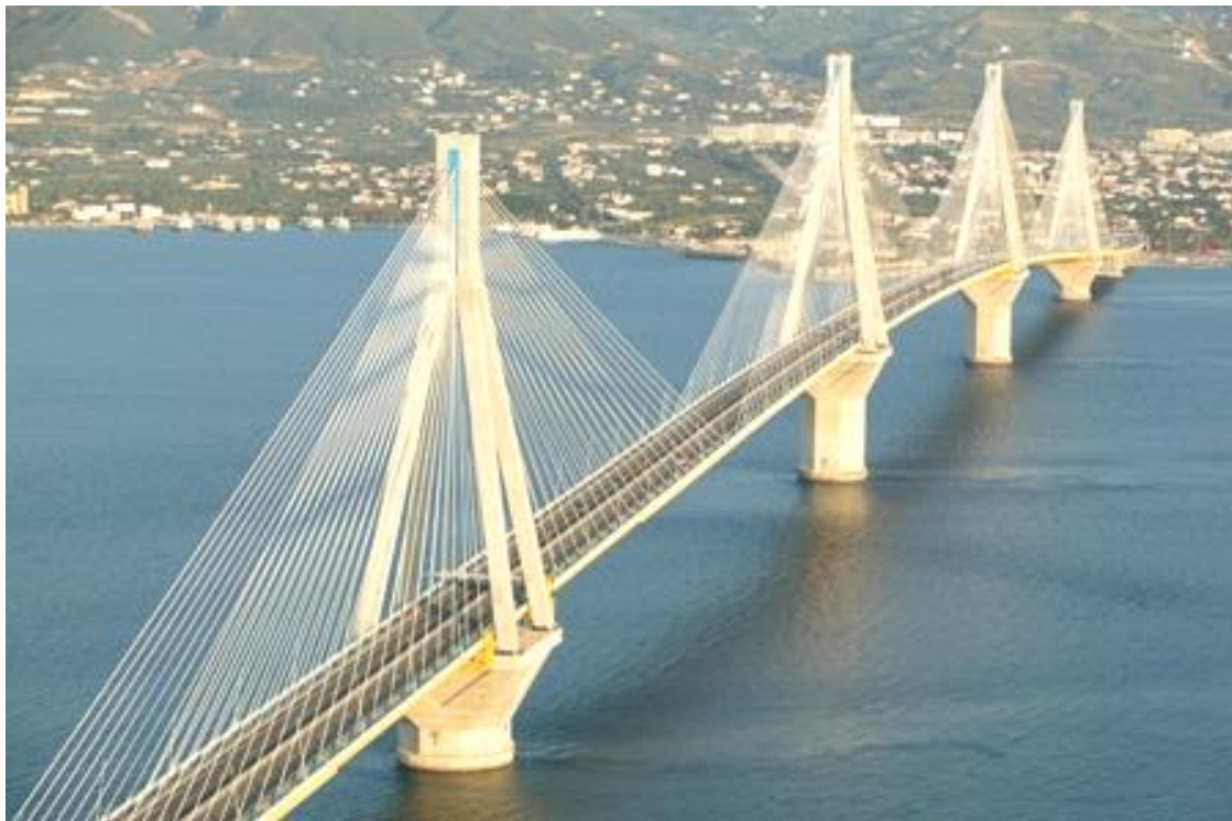
Γέφυρα Ρίου – Αντιρρίου
