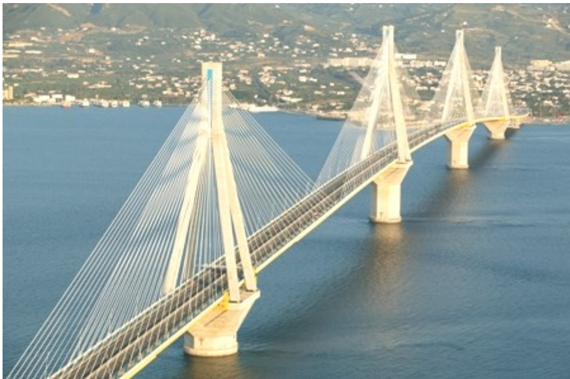
Γέφυρα Ρίου – Αντιρρίου
