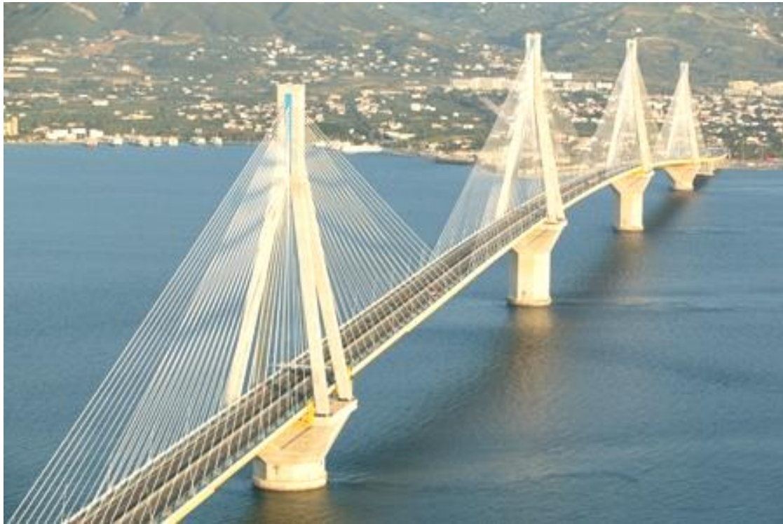
Γέφυρα Ρίου – Αντιρρίου
